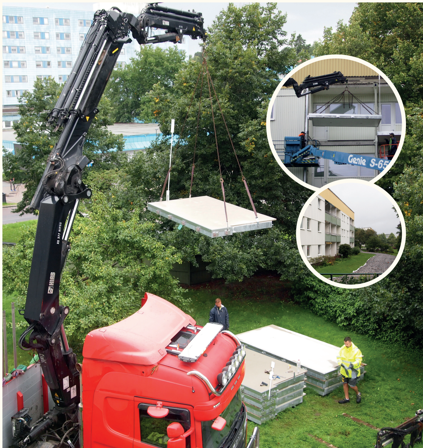
Monteringen av de nya balkongerna.
